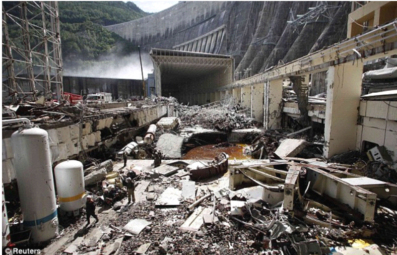
图 1 2#机组破坏情况
